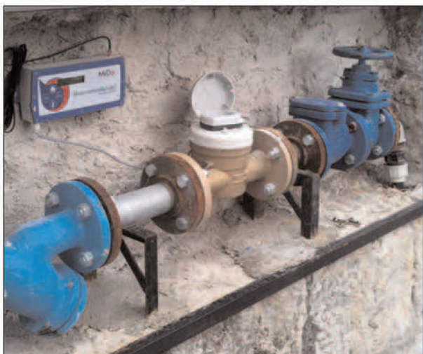
"Idrocontatore Remoto", sistema wireless autoalimentato per il monitoraggio, tele lettura e il fault detection/isolation della rete idrica (dispositivo di telelettura per il monitoraggio e il controllo remoto delle risorse idriche) - Domenico Lamboglia, Miriam Surro di MIDO Laboratorio
